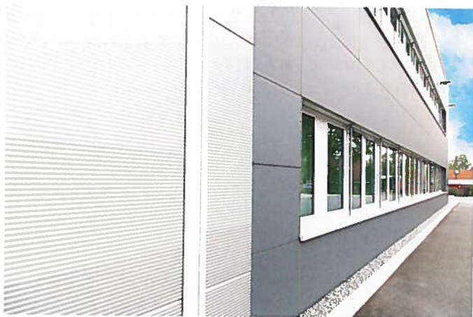
**Bild 5.** Auch für die Fenster und zweiflügeligen Türanlagen wählte man hochwärmedämmende Profilkonstruktionen; eine verdeckt montierte Raffstoreanlage hinter der VHF-Konstruktion gewährleistet den geforderten Sicht- und Sonnenschutz
