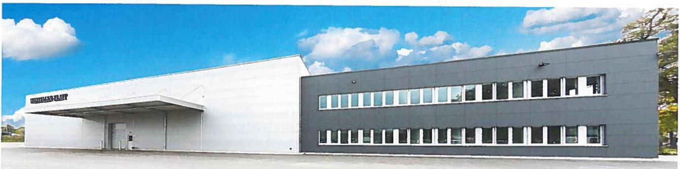
Bild 3. Eine Vorhangfassade mit großformatigen Faserzementtafeln kennzeichnet das repräsentative Bürogebäude des Produktionskomplexes
